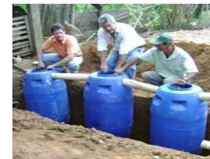
Ela deverá ser instalada a 50 metros de distância de minas, cisternas e de qualquer curso d'água, para evitar possíveis contaminações, no caso de eventual vazamento.
